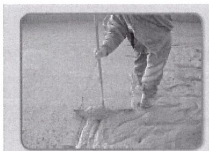
2. executare pardoseală cu ADEPLAST TERMOȘAPĂ
